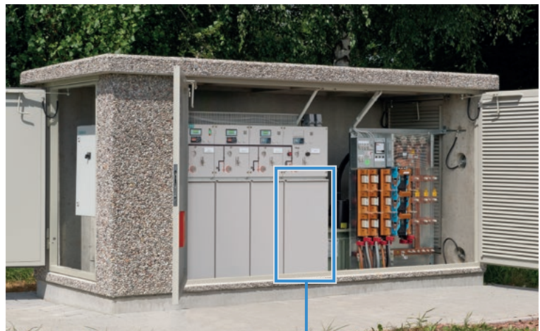
INTELLIGENTE ORTSNETZSTATION (Quelle: Siemens)
